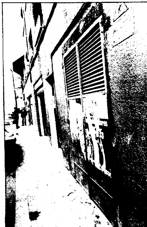
Este es el generador que causó el problema
