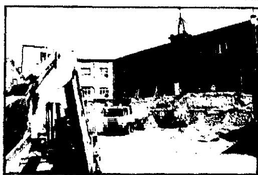
Las máquinas ya están trabajando
