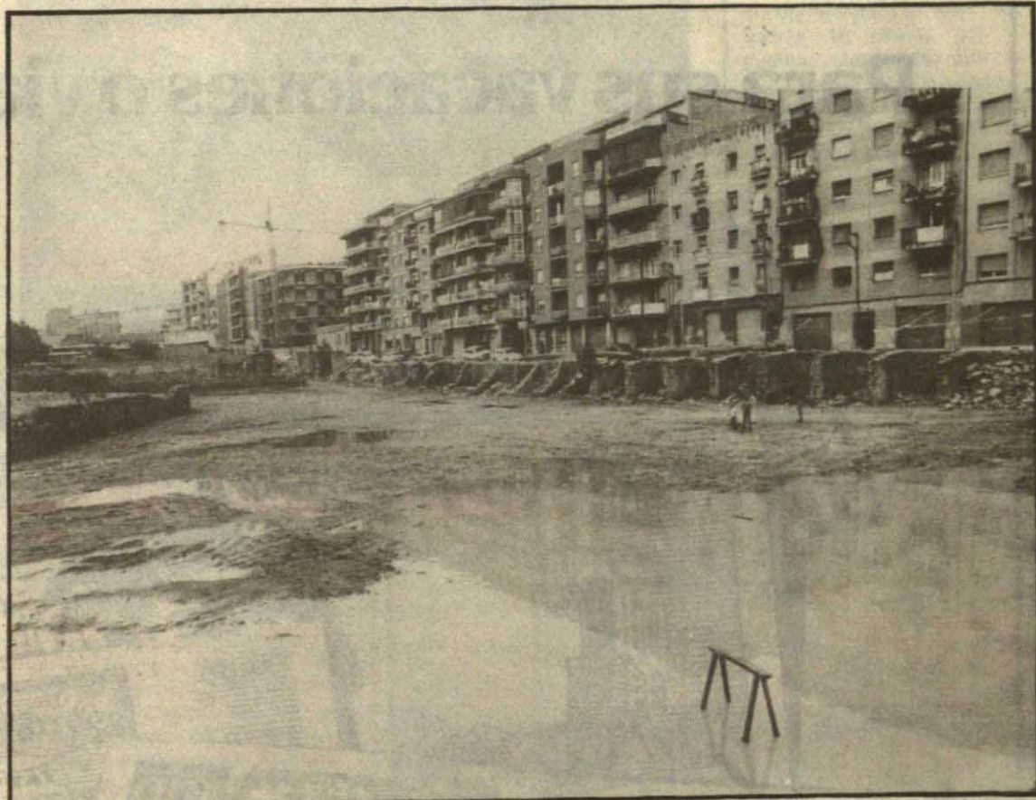
En las proximidades de la Pallaresa el cinturón se hará túnel
