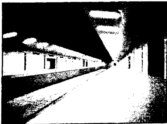
La estación de Plaça de la Vila, casi terminada
